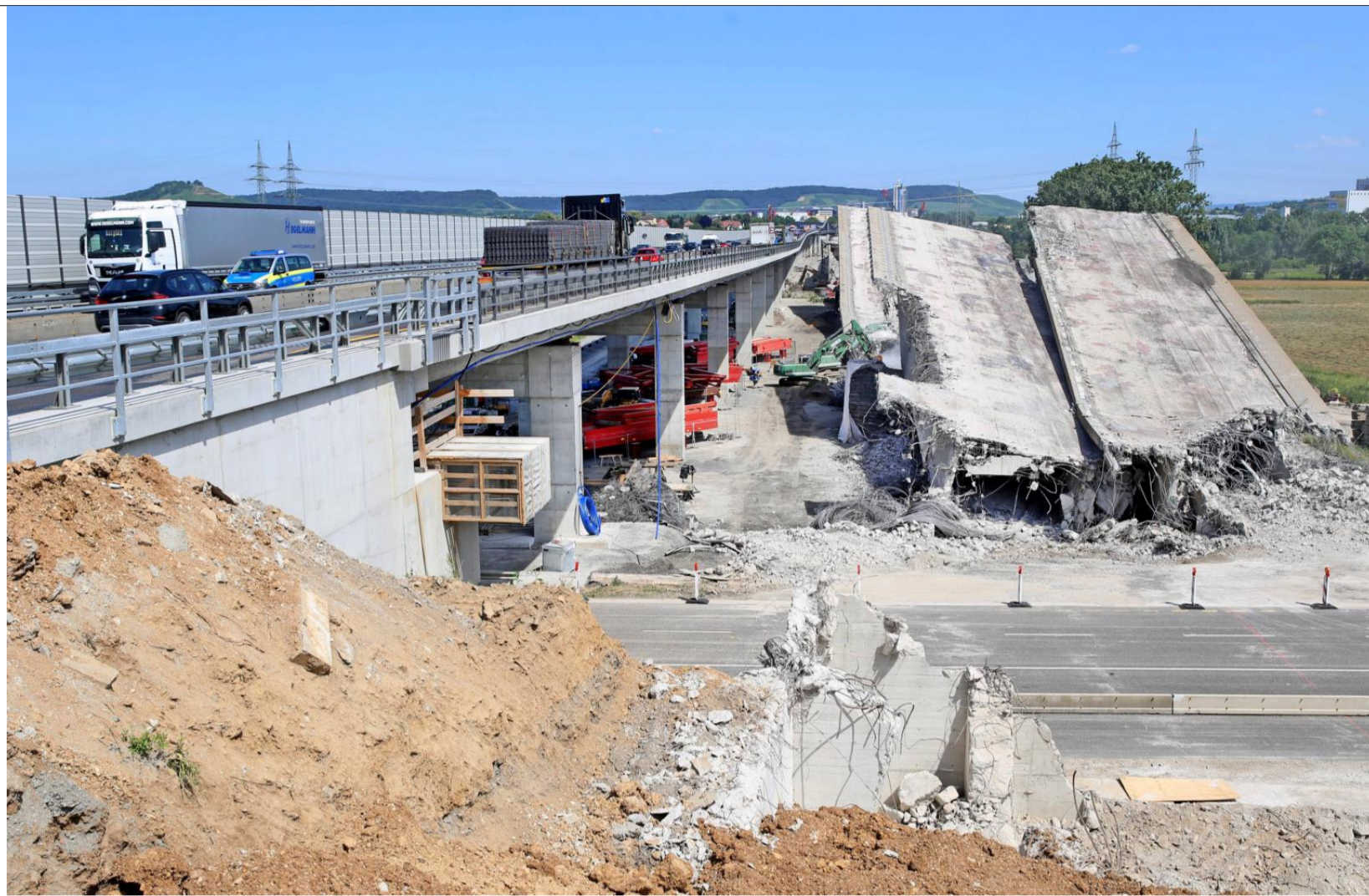
12 500 Tonnen schwer: Ein Teilstück der ehemaligen Autobahnbrücke über den Neckar wird zwischen Heilbronn und Neckarsulm-Obereisesheim zerlegt.
